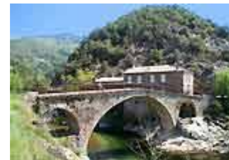
Le Pont du Gua
