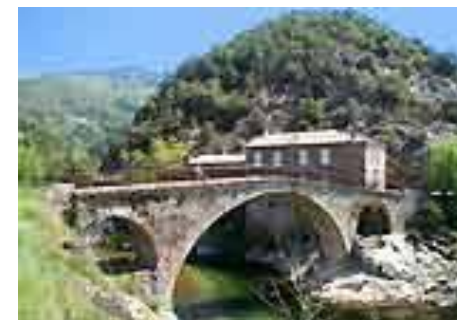
Le Pont du Gua
